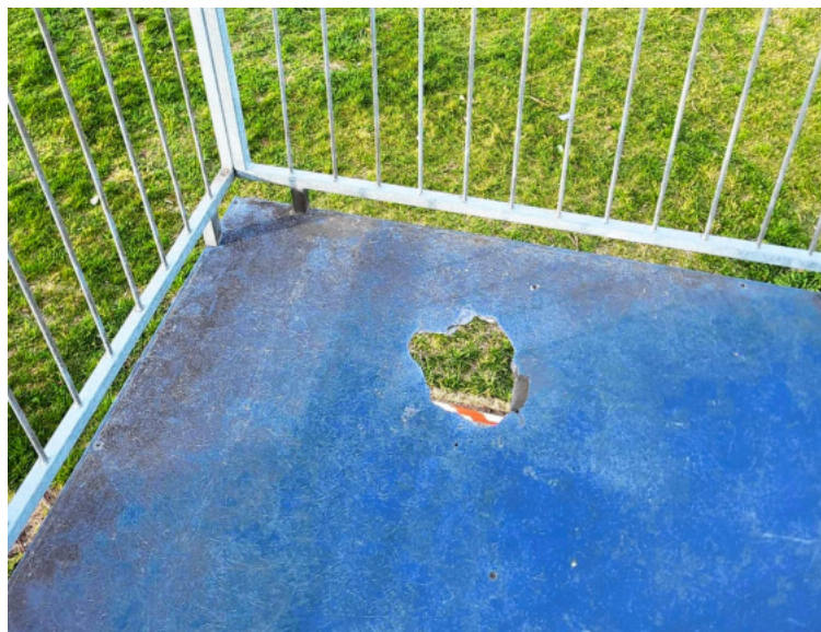
▲ Der Belag am Funccourt wurde schwer beschädigt und regelrecht durchlöchert hinterlassen.
