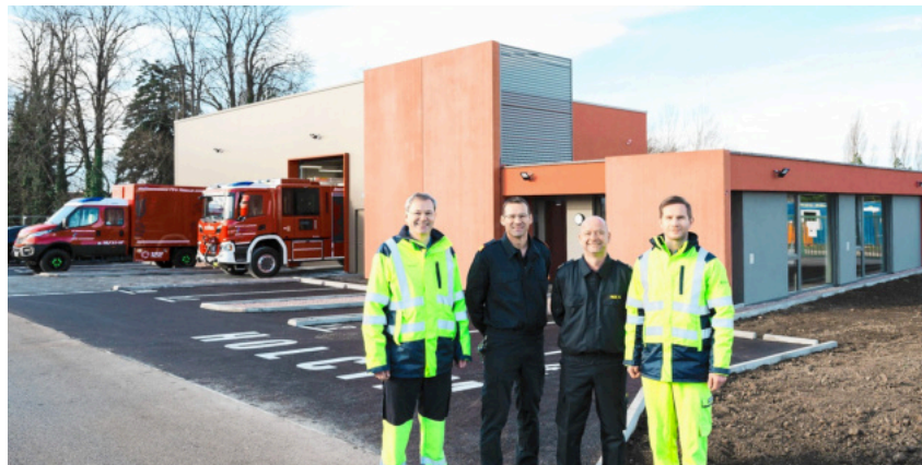
Werksleiter Helmut Reiterer, Kommandant Michael Kopf, Günther Peck und Hannes Medwenitsch vor dem neuen Feuerwehr-Gebäude. Foto: Holcim Österreich/S. Germershausen
