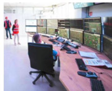
▲ Über diese Schaltzentrale werden die Abläufe gesteuert.
